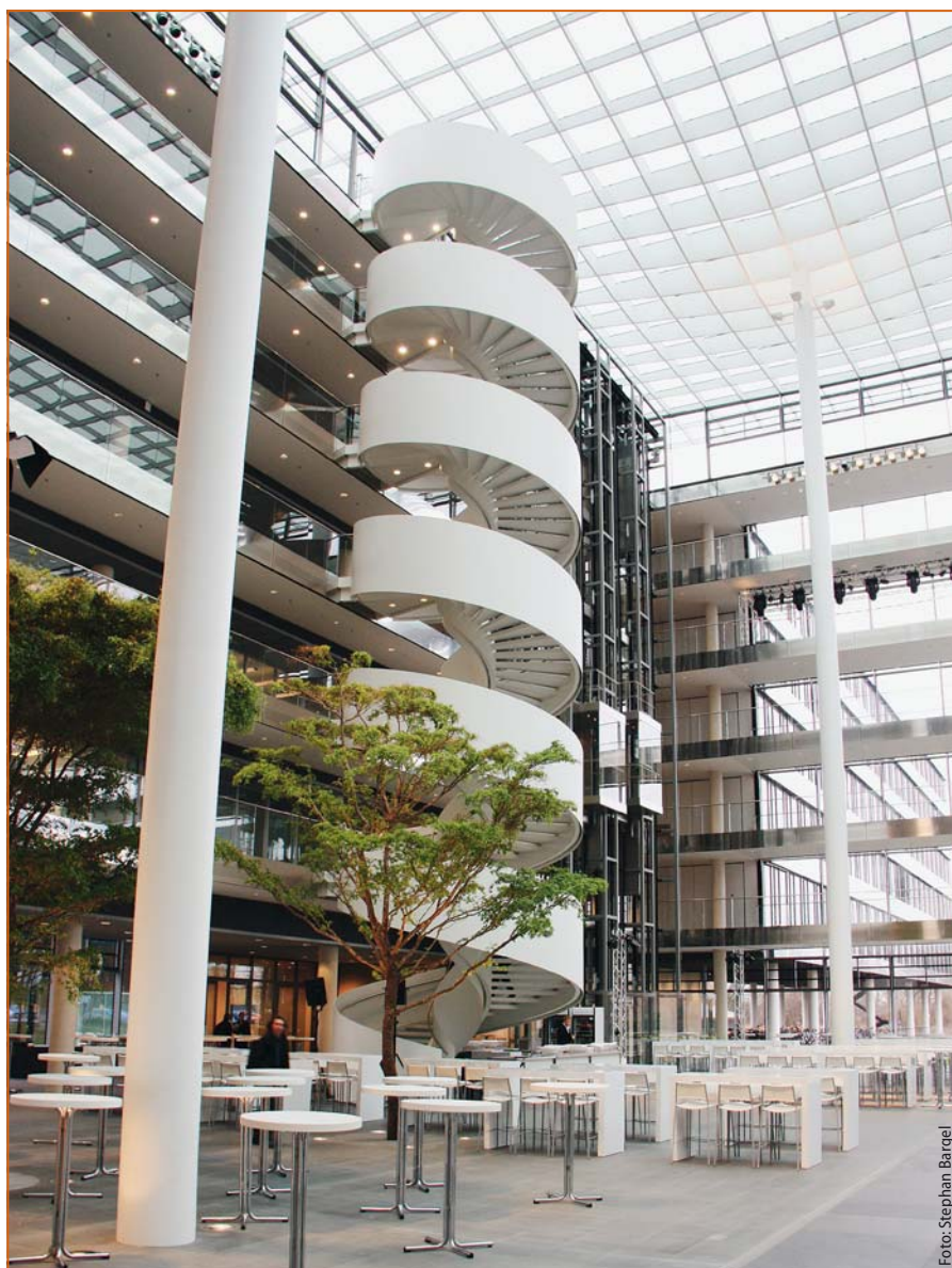
Abb. 5: Freitreppe im Atrium. Die im Hintergrund erkennbaren Galeriebrücken sowie das Dach des Atriums konnten nach ingenieurmäßigem Nachweis als ungeschützte Stahlkonstruktionen errichtet werden.
