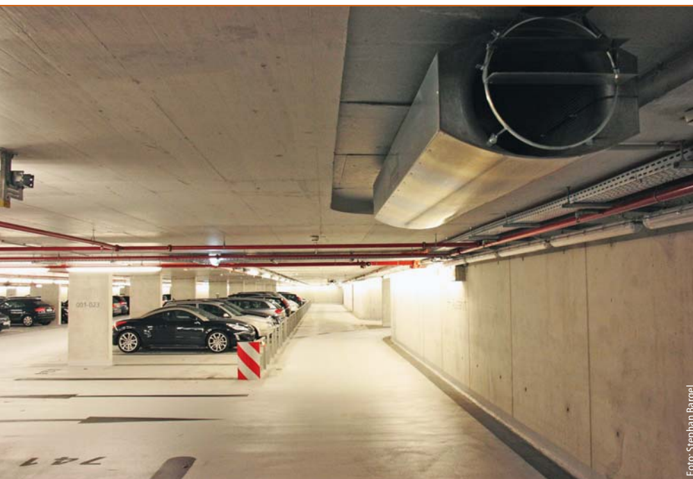
Abb. 3: Die Großgarage für 611 PKW konnte aufgrund des verbauten Impuls-Ventilationssystems ohne bauliche Unterteilungen und mit überlangen Fluchtwegen realisiert werden.
